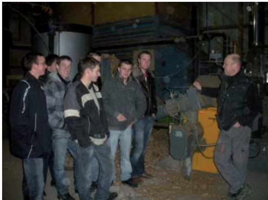
Jean-Paul Mazé explique le fonctionnement de la chaudière.
