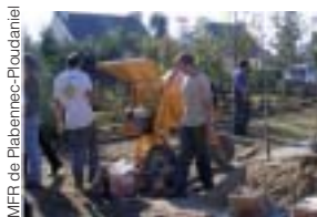
MFR de Plabennec-Ploudaniel Réalisation d'un box de compostage par les stagiaires en certificat de maçonnerie paysagère.
